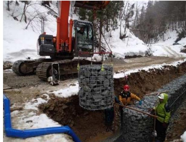
クレーン機能付きバックホウによる据付け
