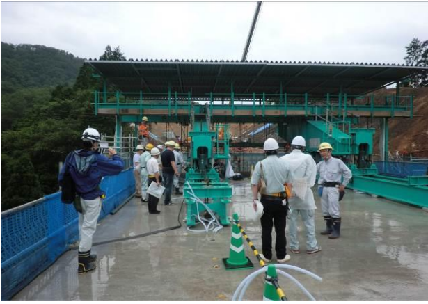
㈱ピーエス三菱側の現場見学状況
