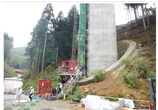
P3 橋脚のエレベーター（橋脚施工の土留は竹割り型で施工されている：橋脚は鋼管コンクリート複合型式 → コンクリートの中は鋼管が配置され、外周鉄筋の帯鉄筋はPC 鋼より線を使用している）
