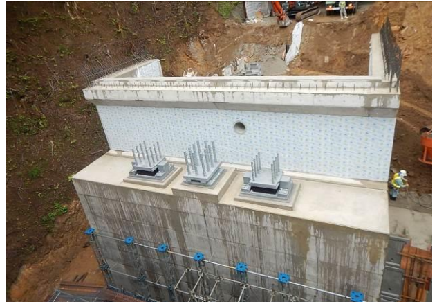
A1 橋台（沓は設置完了、手前は側径間の支保工、奥はトンネル）
