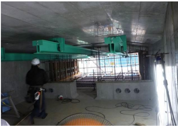
ワーゲン下側の箱桁内部（ゲビンでワーゲンの反力を取り、ゲビンで型枠支保工を吊っている：手前コンクリートの孔が外ケーブルの通る孔）
