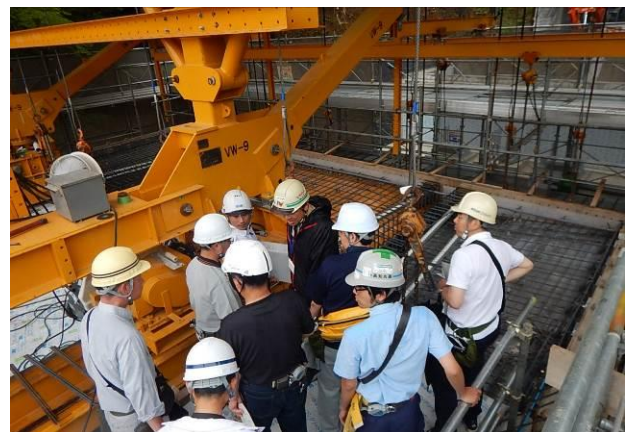
西松建設(株)側の現場見学状況
