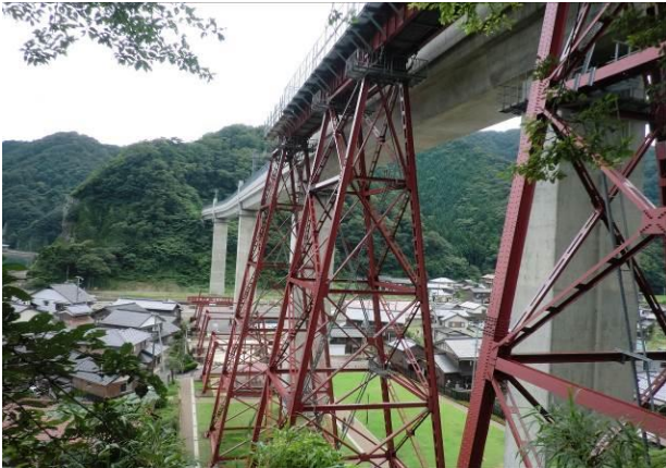
起点側が S 字になっているのは旧橋と新橋で 7m 架設位置が違うため
