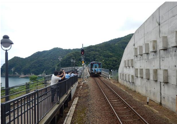
起点側が S 字になっているのは旧橋と新橋で 7m 架設位置が違うため
