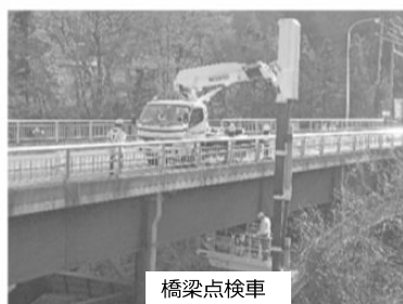
移動式狭橋梁検査路 ブリッジハンガー
