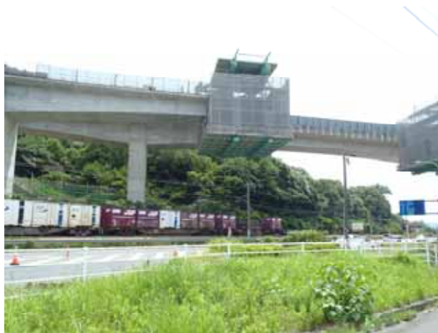
JR 線、県道上空でのワーゲン施工。
