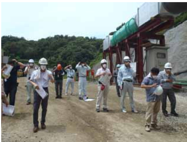
防塵マスクを着用し、トンネル坑内へ。
