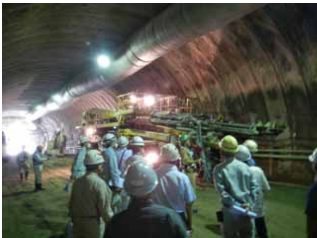
三浦所長による工事説明。
