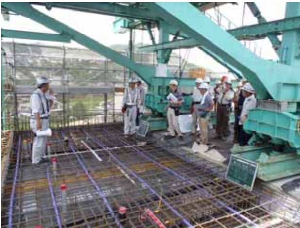
ワーゲン内での工法説明。
