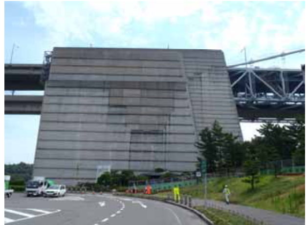
橋台内を見学したアンカレイジ(A1橋台)。
