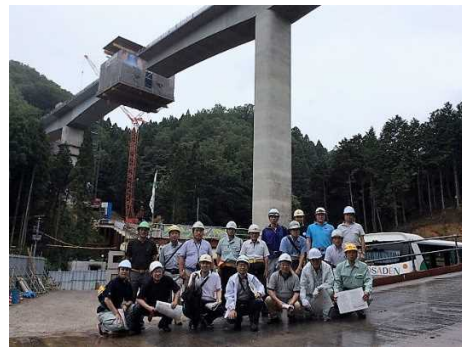
写真 7 八鹿日高道路 青山川橋 (H28 年)
