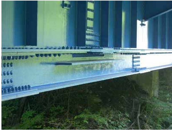
大砂橋の主桁の増桁（主桁結合部）
