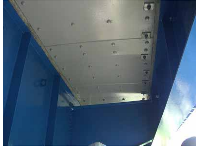
鋼板接着による床版補強
