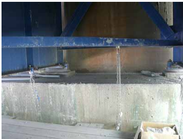
取替前の支承
