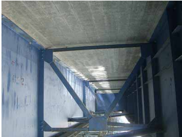
補強前の床版
