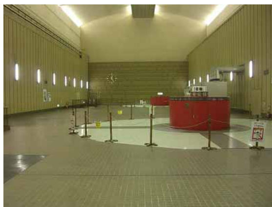
地下1階全景（奥が2号機）
