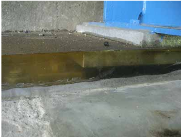
取替られた大砂橋の支承
