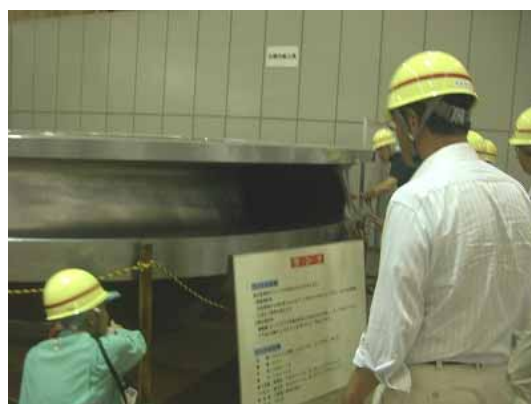
交換した水車ランナ
