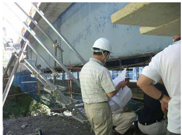
北村商事の西森現場監督による施工計画の説明
