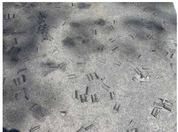
凍結防止の舗装
