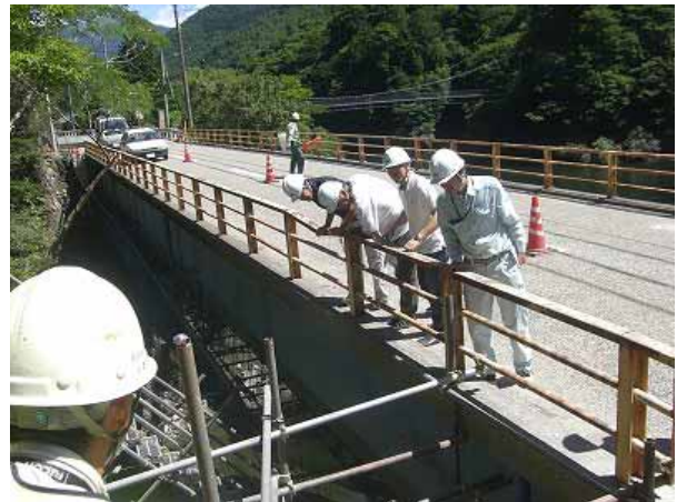
角堂橋の橋面
