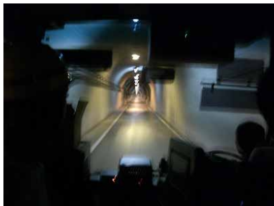
長さ900mのトンネルを通過して地下へ
