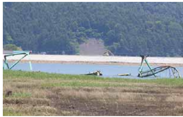
約800m上流に押し流されたトラス橋の一部
