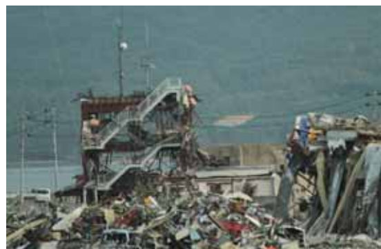
鉄骨だけになった防災対策庁舎
