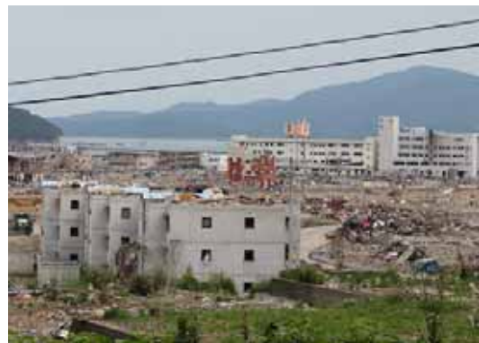
木造家屋はすべて流され残ったのはRCのビルだけ
