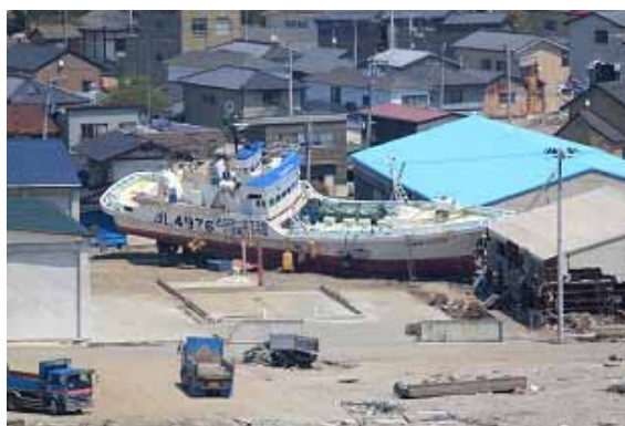
凶器と化して川口町の建物を破壊する漁船
