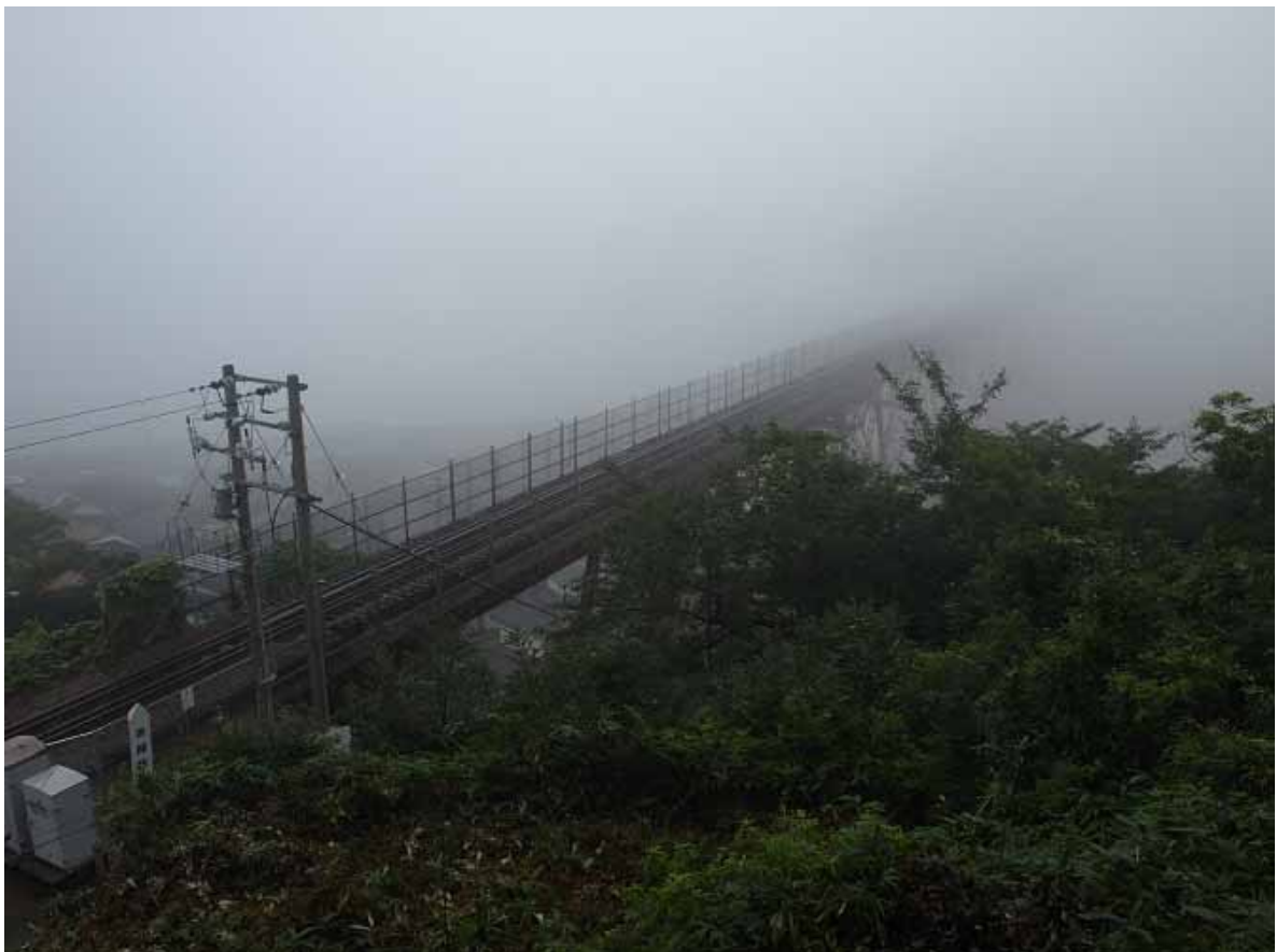
霧の余部橋梁
