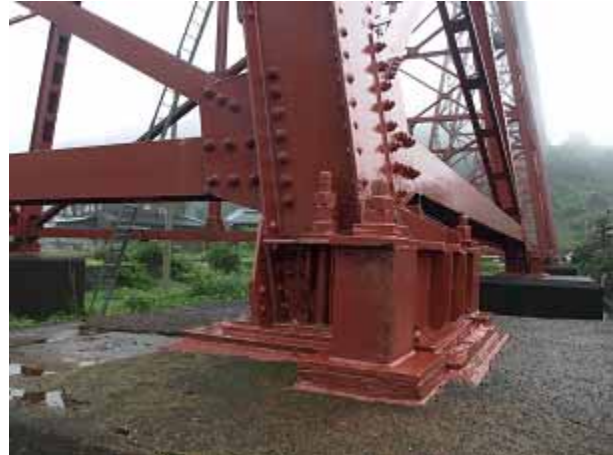
補強された橋脚基部
