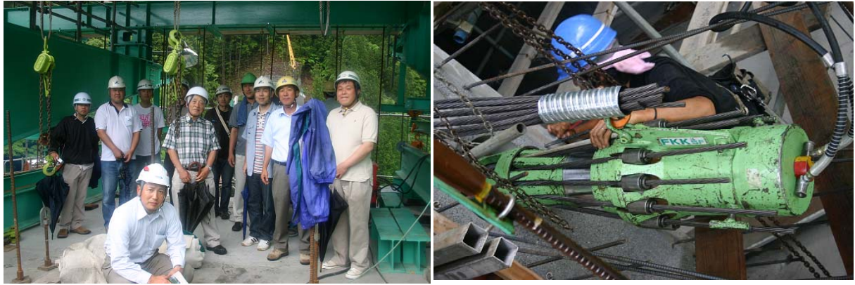
P1 橋脚の上に登り、主ケーブルの緊張作業を見学
