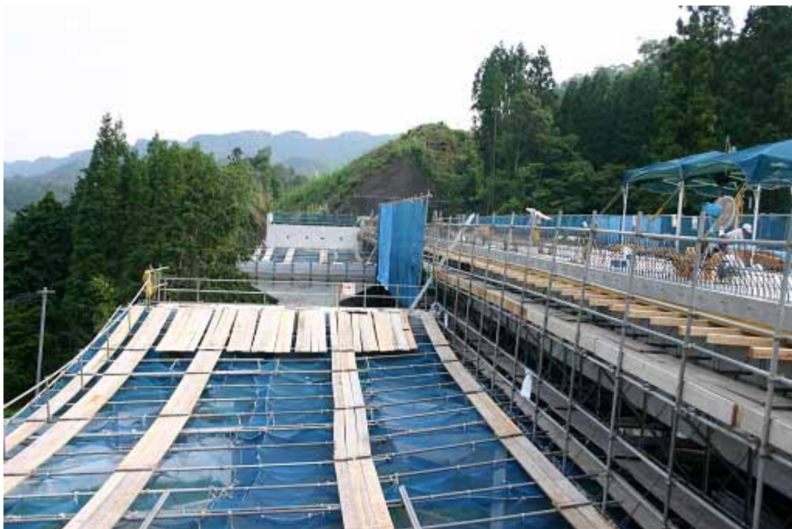
3 径間連結 PC コンボ橋の工事現場
