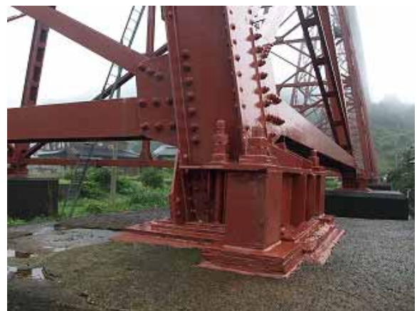
補強された橋脚基部
