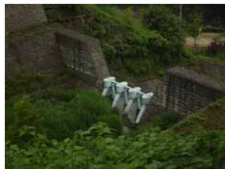
写真 12 戸ノ谷堰堤・副堤
