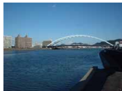
写真 8 ニールセンローゼ橋
