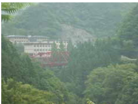
写真 9 曲弦ワーレントラス橋
