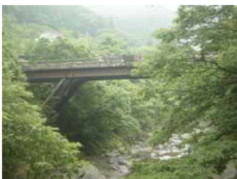
写真 10 型ラーメン橋
