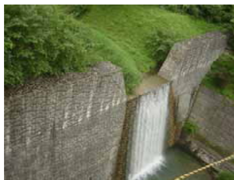
写真 11 戸ノ谷堰堤・本堤
