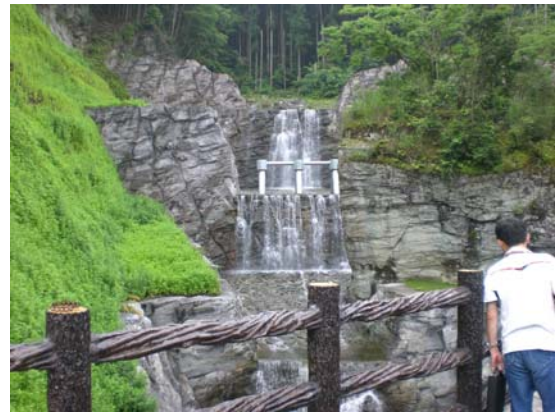
かずら橋前の砂防ダム（右が本物）
