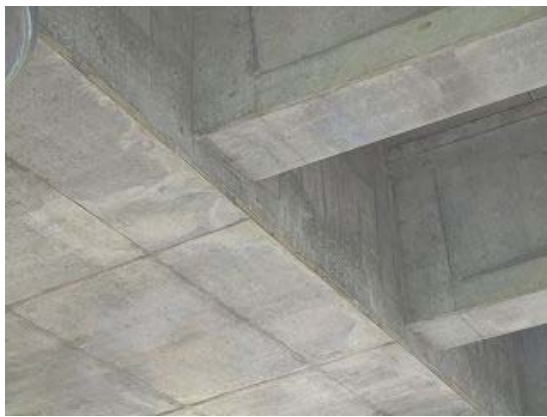
プレテン桁とポステン部の接合
