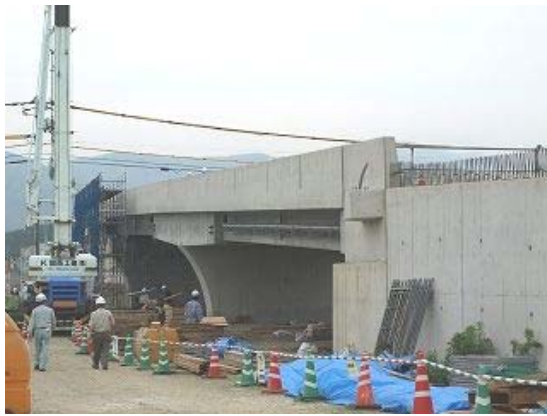
牛島高架橋 施工状況
