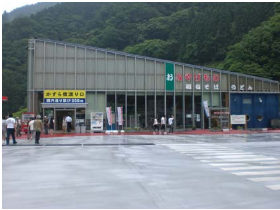
新しくなった かずら橋渡り口
