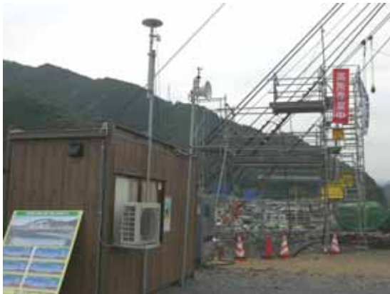
測定の為の事務所 GPS アンテナ
