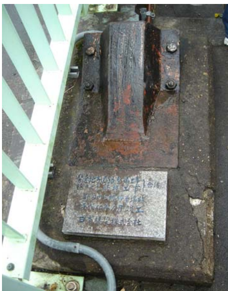
写真 9 吊橋だったことの痕跡
