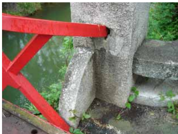
写真 3 手すり部拡大(左岸側)
