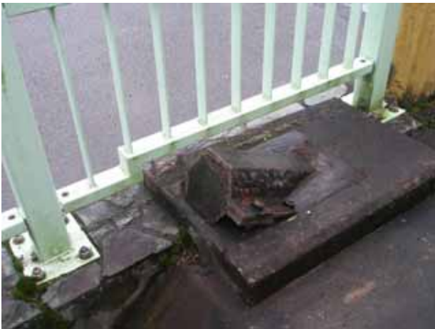
写真 9：吊り橋時代のアンカー部
