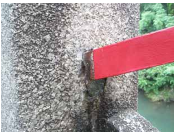
写真 5：左岸側手摺（アングル）の状況
