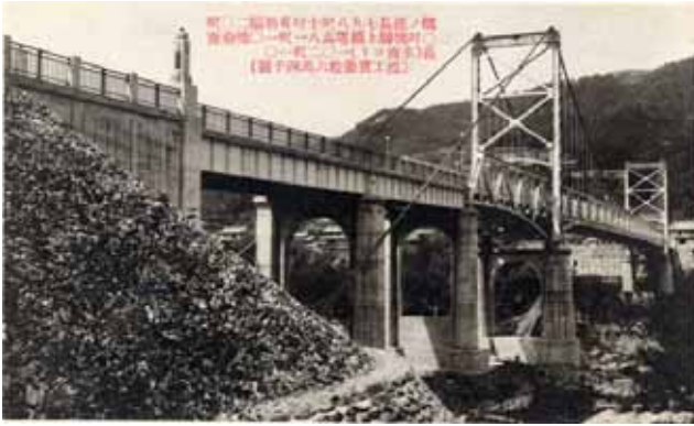
写真 8：三好橋（補修前）
